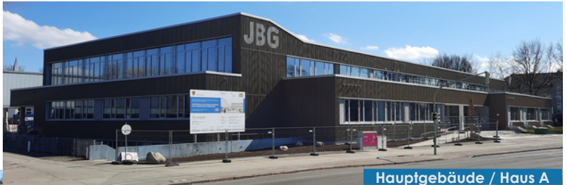
Hauptgebäude / Haus A
