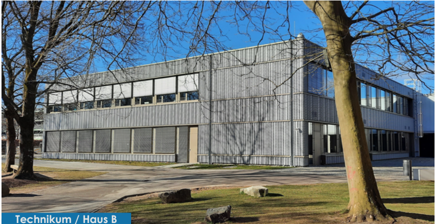
Technikum / Haus B
