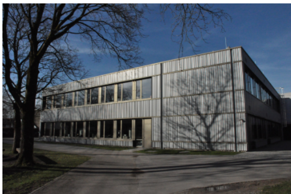
Das Technikum – unser modernes Naturwissenschaftsgebäude
